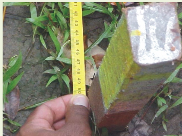
DETALHE DA MEDIÇÃO
