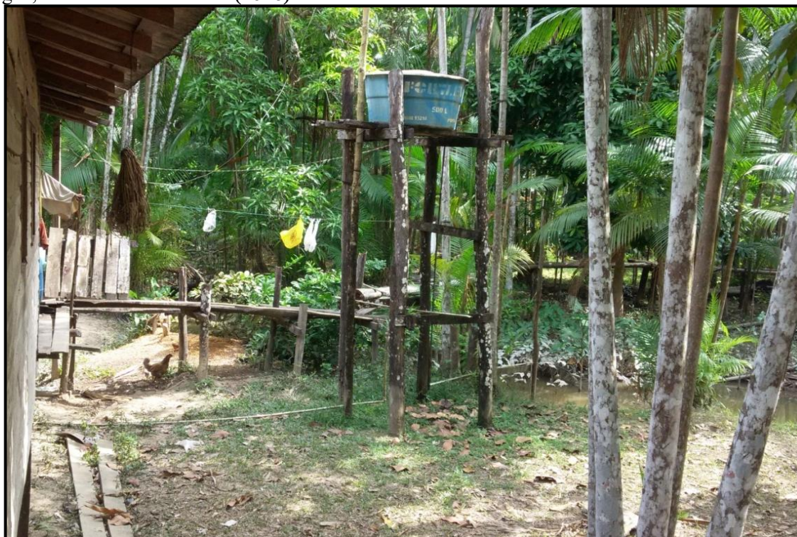
Fotografia 4 – Sistema de coleta de água do igarapé através de bomba para ser armazenada em caixa d'água, na Ilha de Santana-AP (2016)
